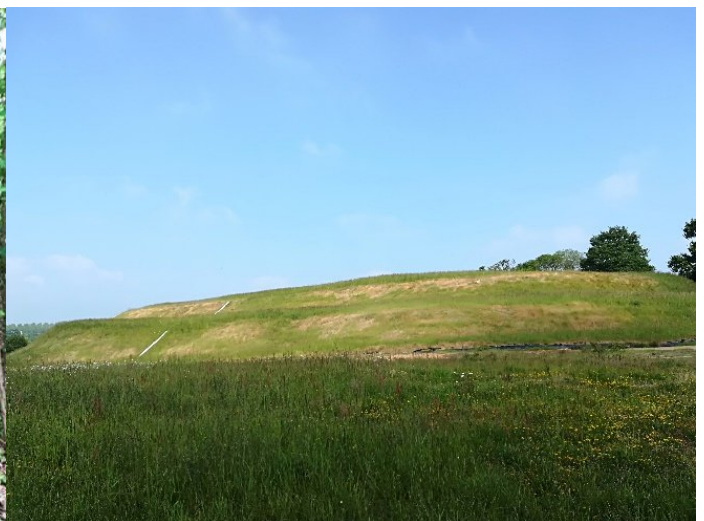
Dépôt de scories confiné et végétalisé source : GEODERIS
