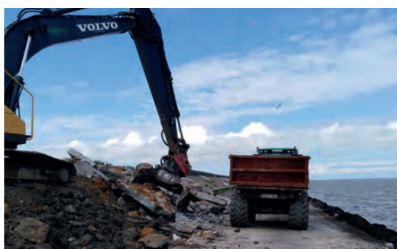
Digue du polder du Dain (Bouin, 85) ©DREAL Pays de la Loire
